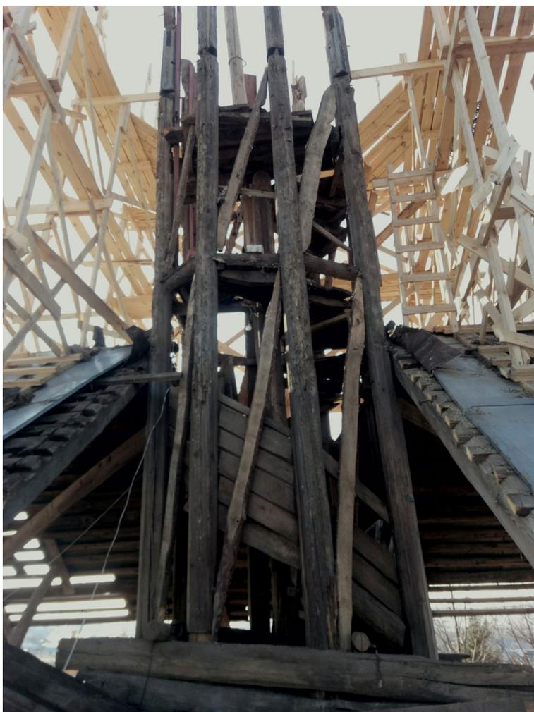
Илл. 38(1). Стропильные ноги и затяжки кровли мечети.
