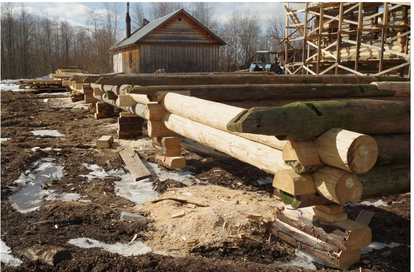
П/4. Установка затяжек конструкции кровли мечети.
