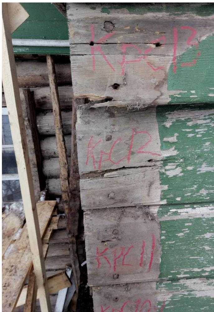
Илл. 18(2). Снятие пилястр крыльца и маркировка подлинной обшивки.
