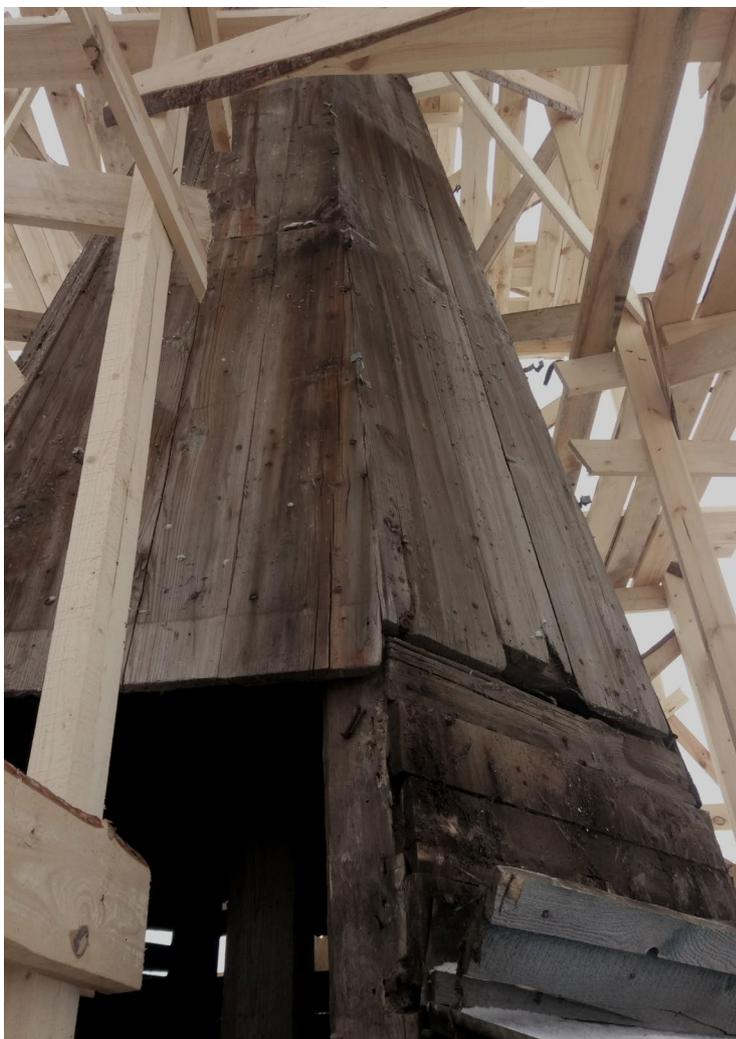
Илл. 13(2). Стропила и затяжки шпиль.
