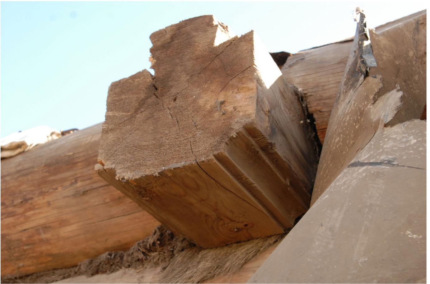
Илл. 43(1). Выпуск балки чердачного перекрытия.
