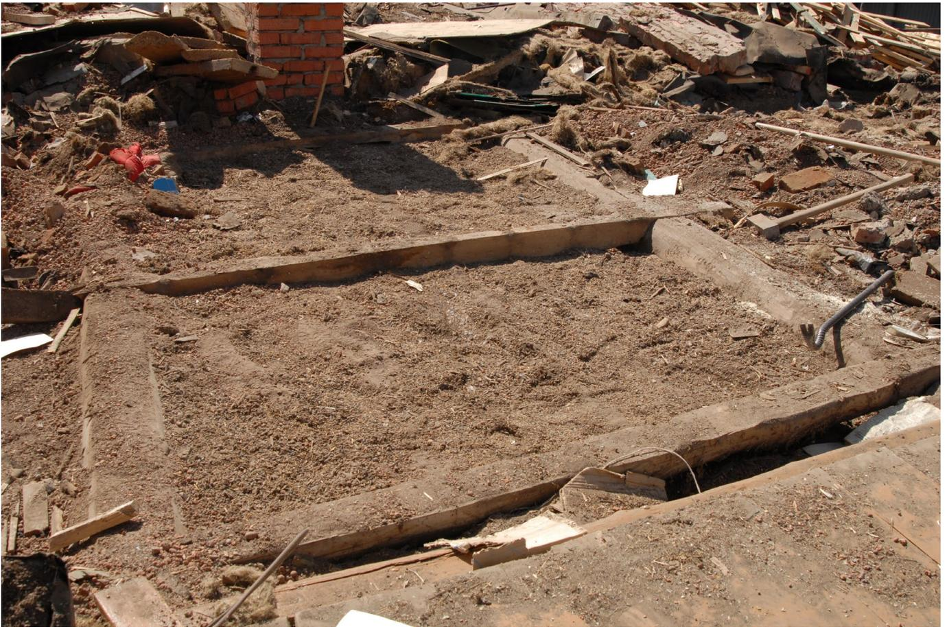
Илл. 50. Конструкция основания пола лестничного холла первого этажа и крыльца.
