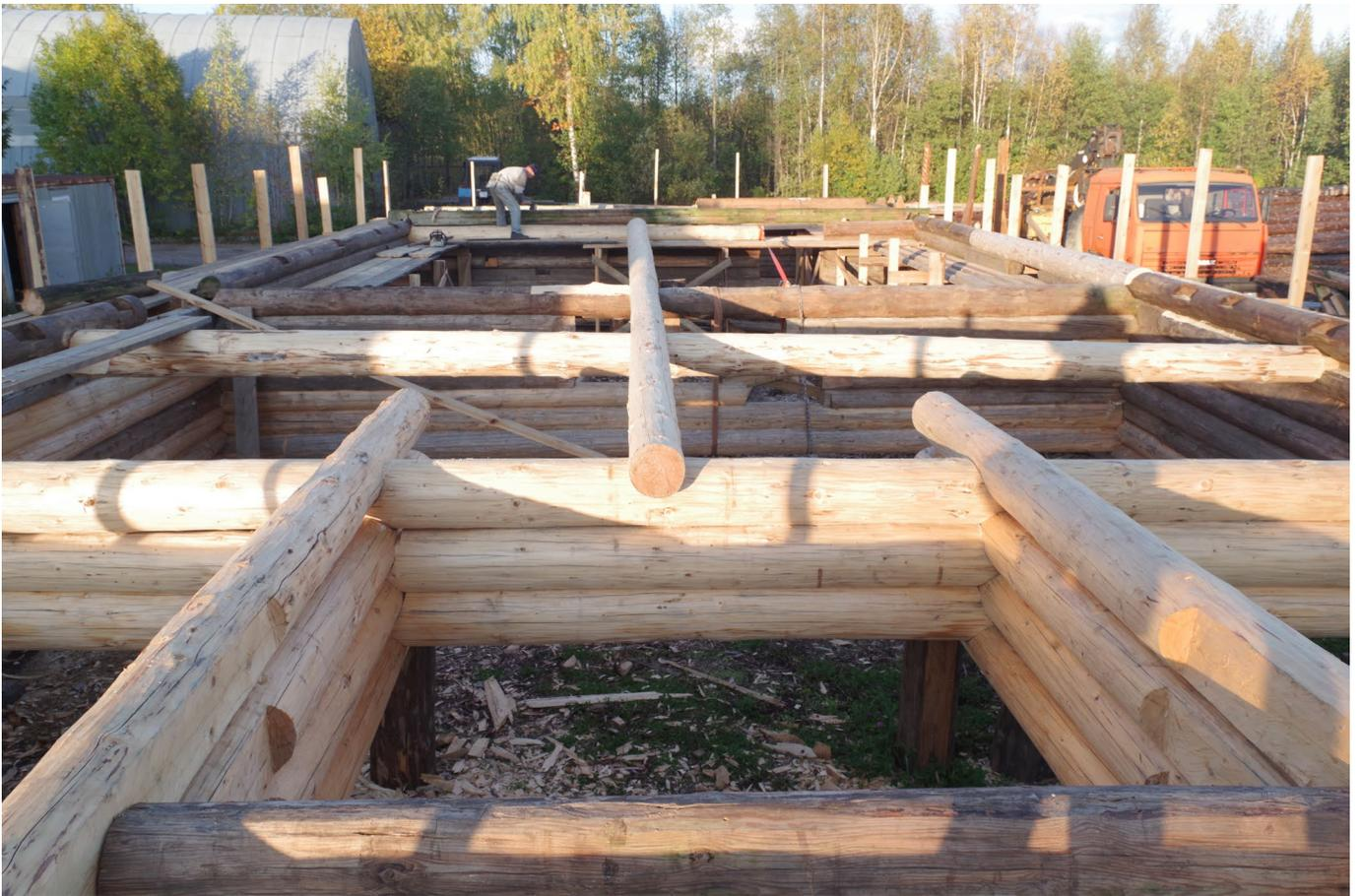
Илл. 57. Сборка сруба. Установка продольной балки перекрытия.
