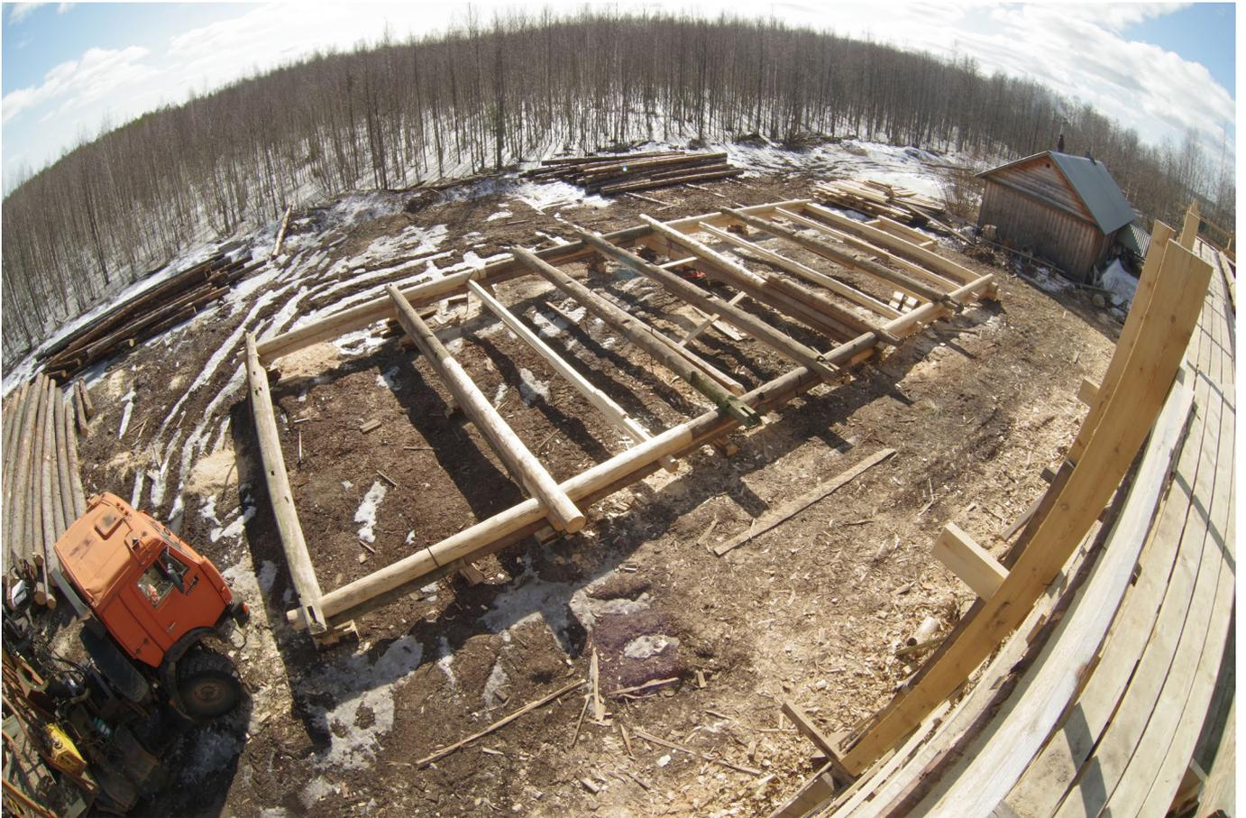
П/3. Венцы №21 и 22, собранные на земле для возведения стропильной конструкции и конструкции минарета.
